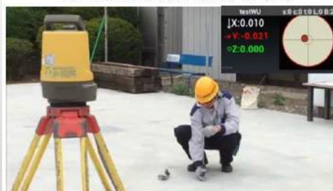
本システムによる墨出し手順 (Step02)
