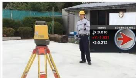
本システムによる墨出し手順 (Step01)
