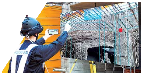
MRデバイスで型枠寸法を計測する
